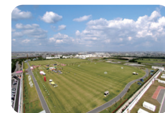
▲中川水循環センターの上部公園 （三郷スカイパーク）
